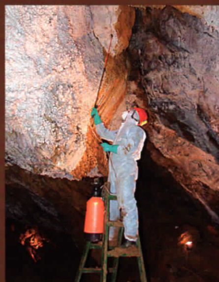
Celoplošná aplikace roztoku peroxidu vodíku vyžaduje odpovídající ochranné pracovní pomůcky.
