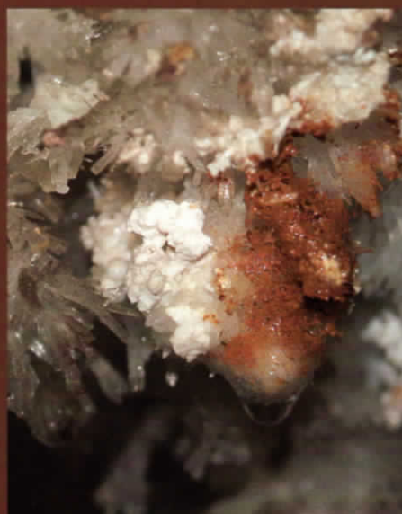
Detail znečištěné výzdoby před provedením postřiku
