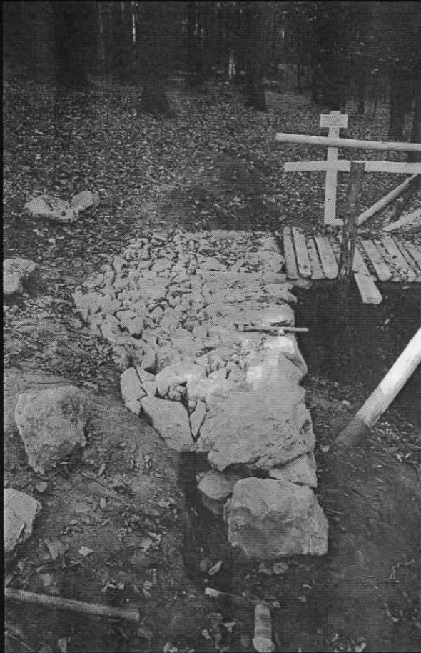
Stabilizace lesní cesty - efektivní využití těžených sedimentů
